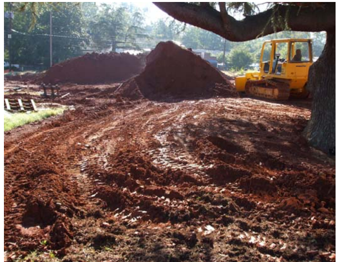
Un gran cantidad de daño pueda ha hecho si los arboles no están protegidos.
