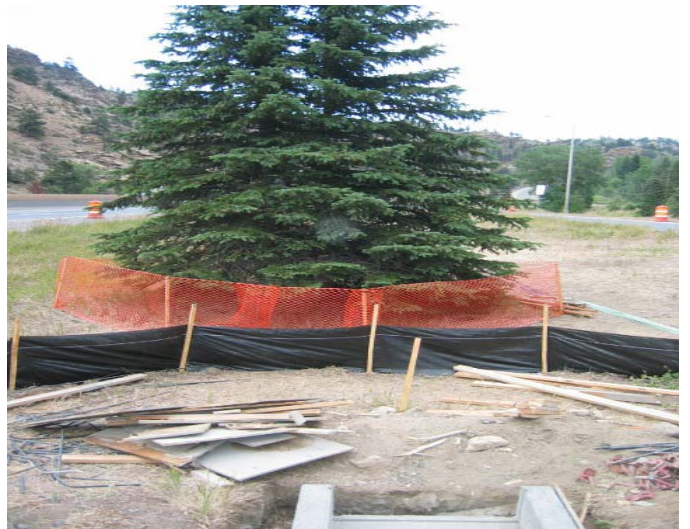
La barrera protege suficiente raices para asegurar que el árbol va a sobrevivir.
